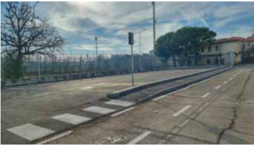
Nuovo parcheggio di Via Turati a fianco del plesso scolastico Alberti
