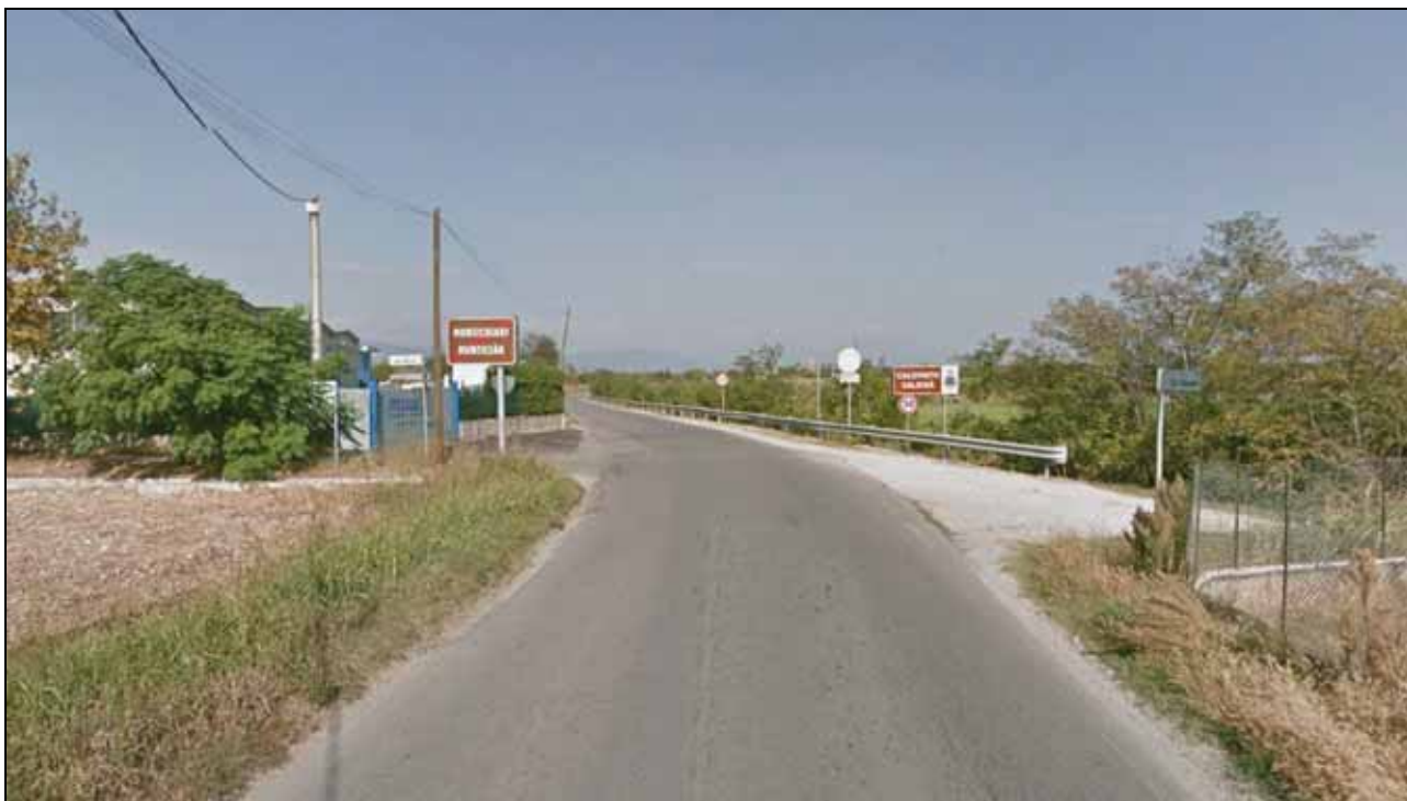
Vista (da via San Giovanni) del punto di innesto della rotonda di collegamento fra il tracciato e via San Giovanni
