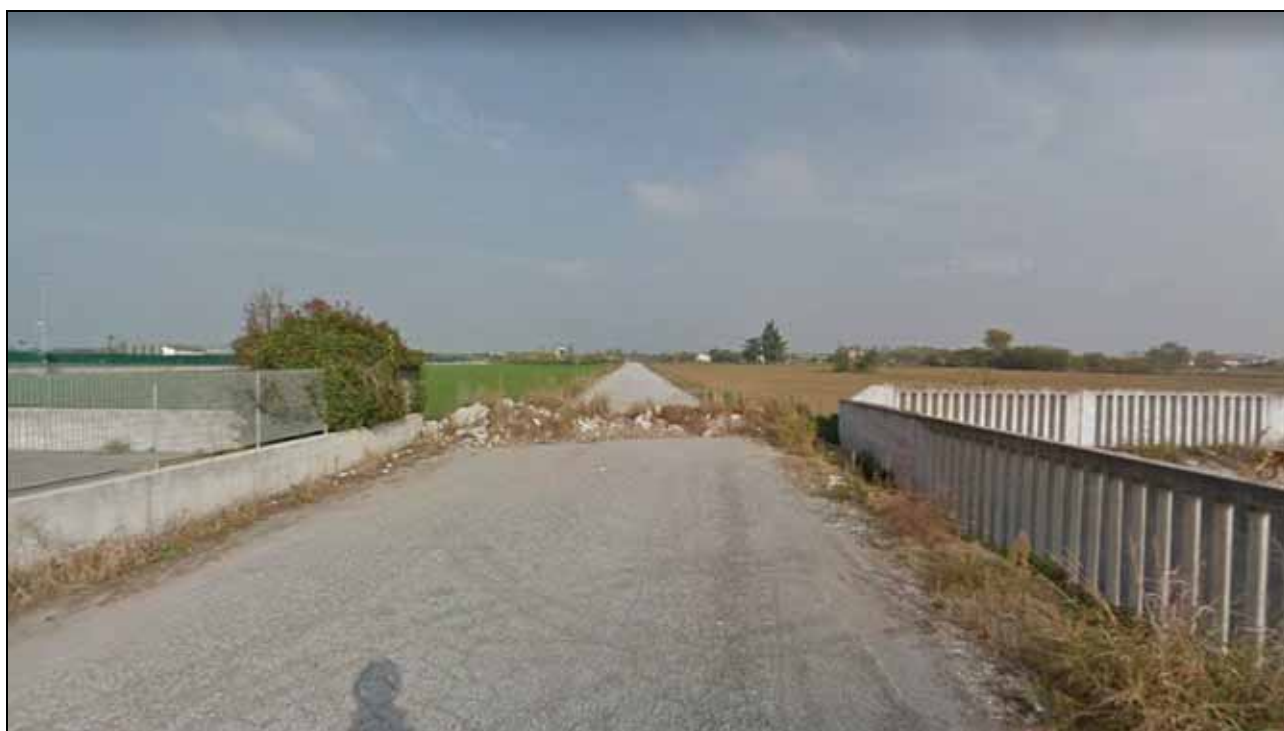
Vista dal tracciato esistente oggetto di riqualificazione e potenziamento
