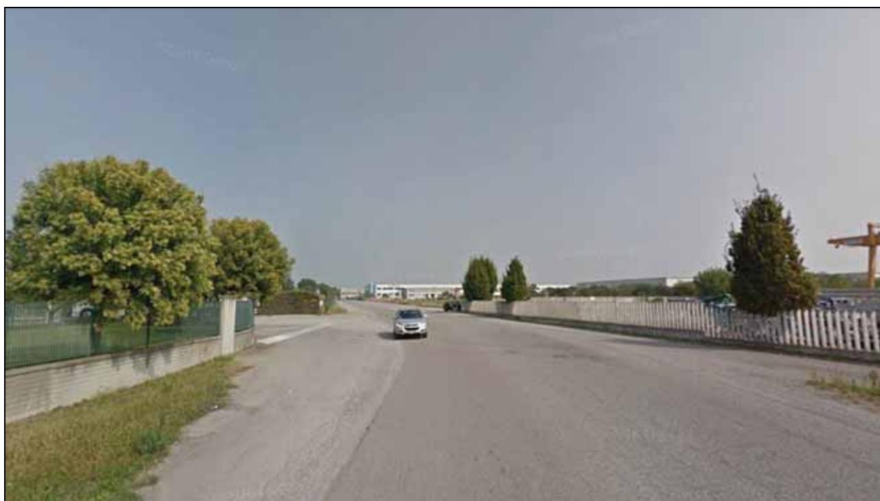
Vista lungo l'infrastruttura esistente, in direzione sud-nord, all'altezza dell'innesto del progetto viario in disamina
