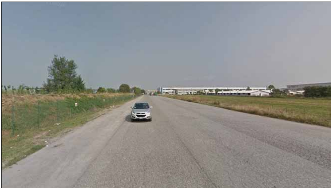
Percorrendo l'infrastruttura esistente, lungo il tratto oggetto di interventi di riqualificazione e potenziamento
