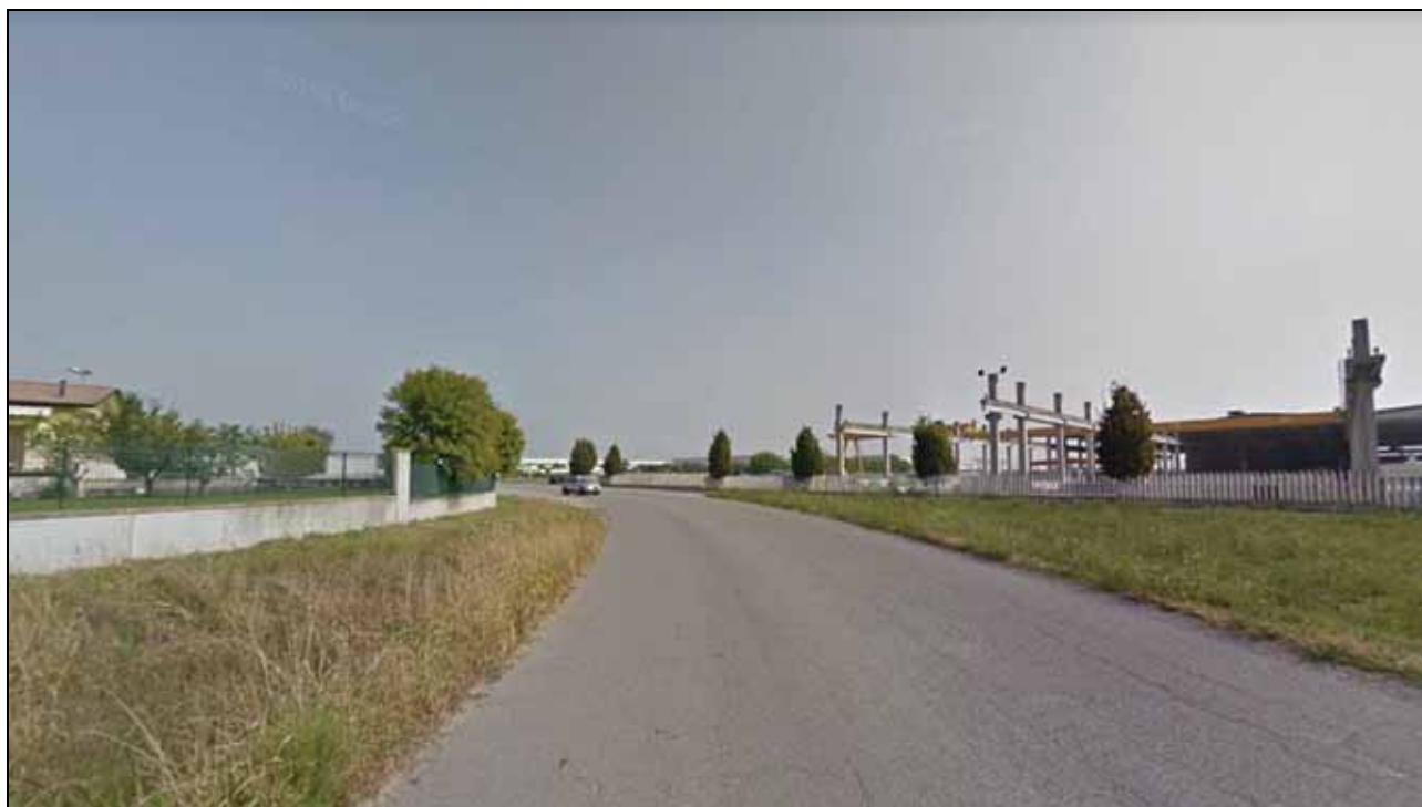
Vista della strada esistente – provenendo da via Brescia - in prossimità dell'innesto del progetto viario in disamina
