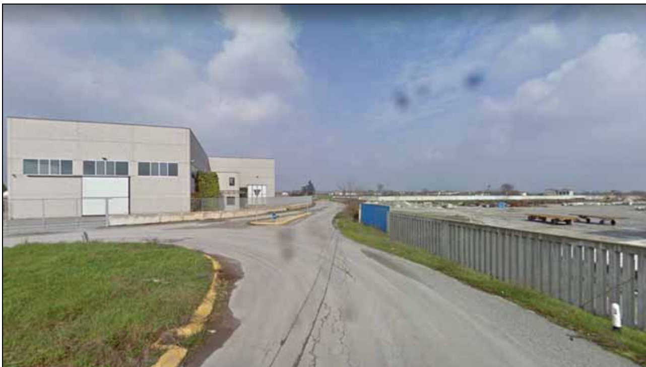
L'infrastruttura esistente, percorrendo la prima rotatoria (da via Brescia) oggetto di riqualificazione e miglioramento
