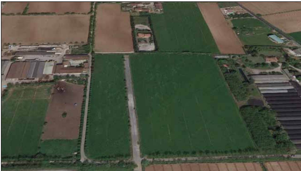
Vista aerea del tracciato esistente, nel tratto fra la seconda e la terza rotonda di previsione
